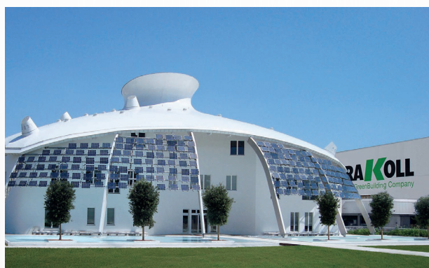
Fig.1 - GreenLab e stabilimento Kerakoll Spa di via Pedemontana a Sassuolo (Mo).
